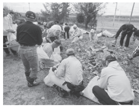
瓦と石を分けて 土嚢袋に入れる作業
